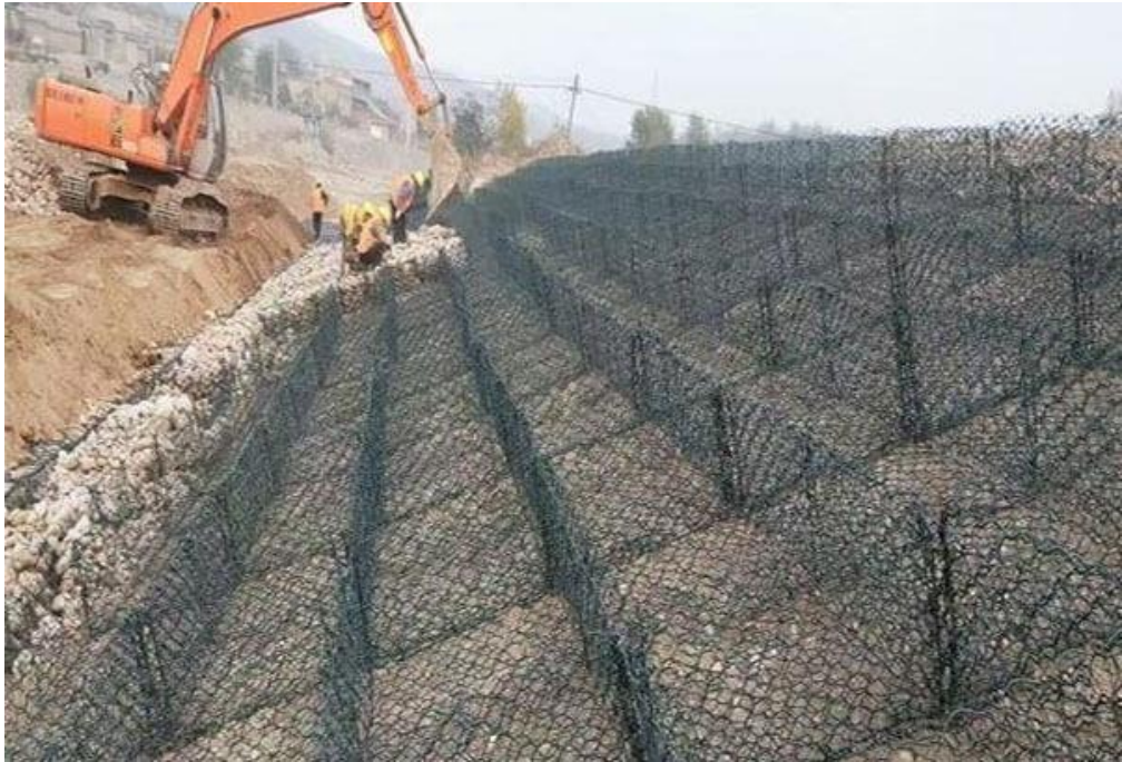
图 2-3 格宾石笼施工示意图
