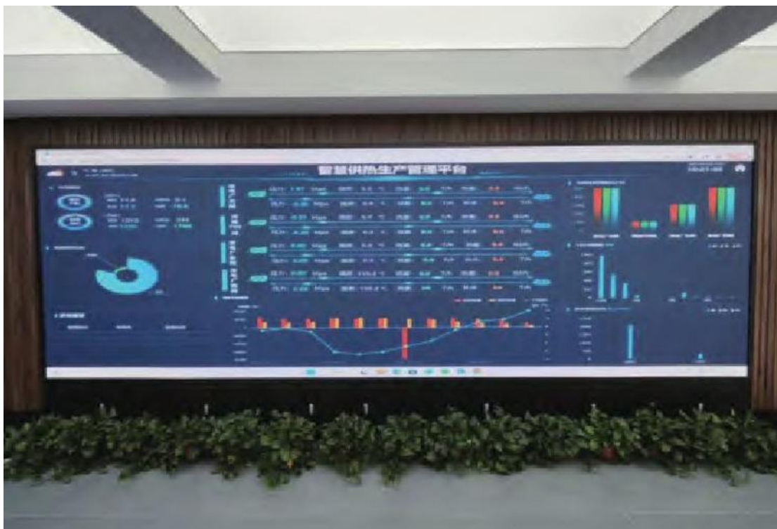
图 1-4 阜新市智慧供热平台
