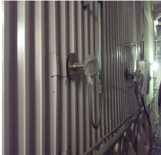
脱硝在线采样探头
