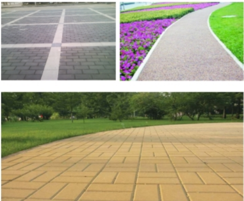
图 6.10 透水铺装示意图
